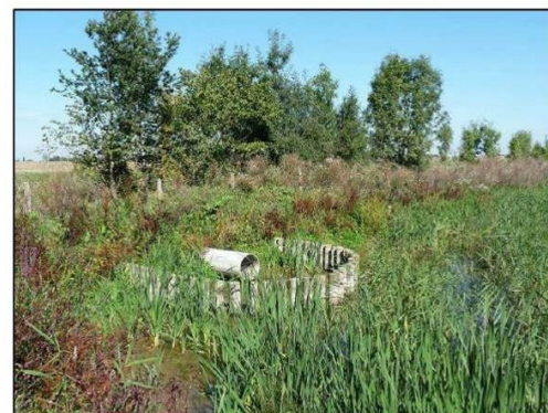
Figure 13 : Exutoire de la ZTHA végétalisée de Rampillon
