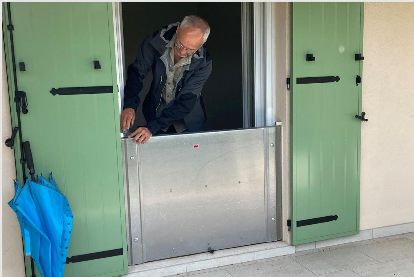
**PHOTO 2 - Réduction de la vulnérabilité de l'habitat aux inondations - Pose d'un batardeau**
