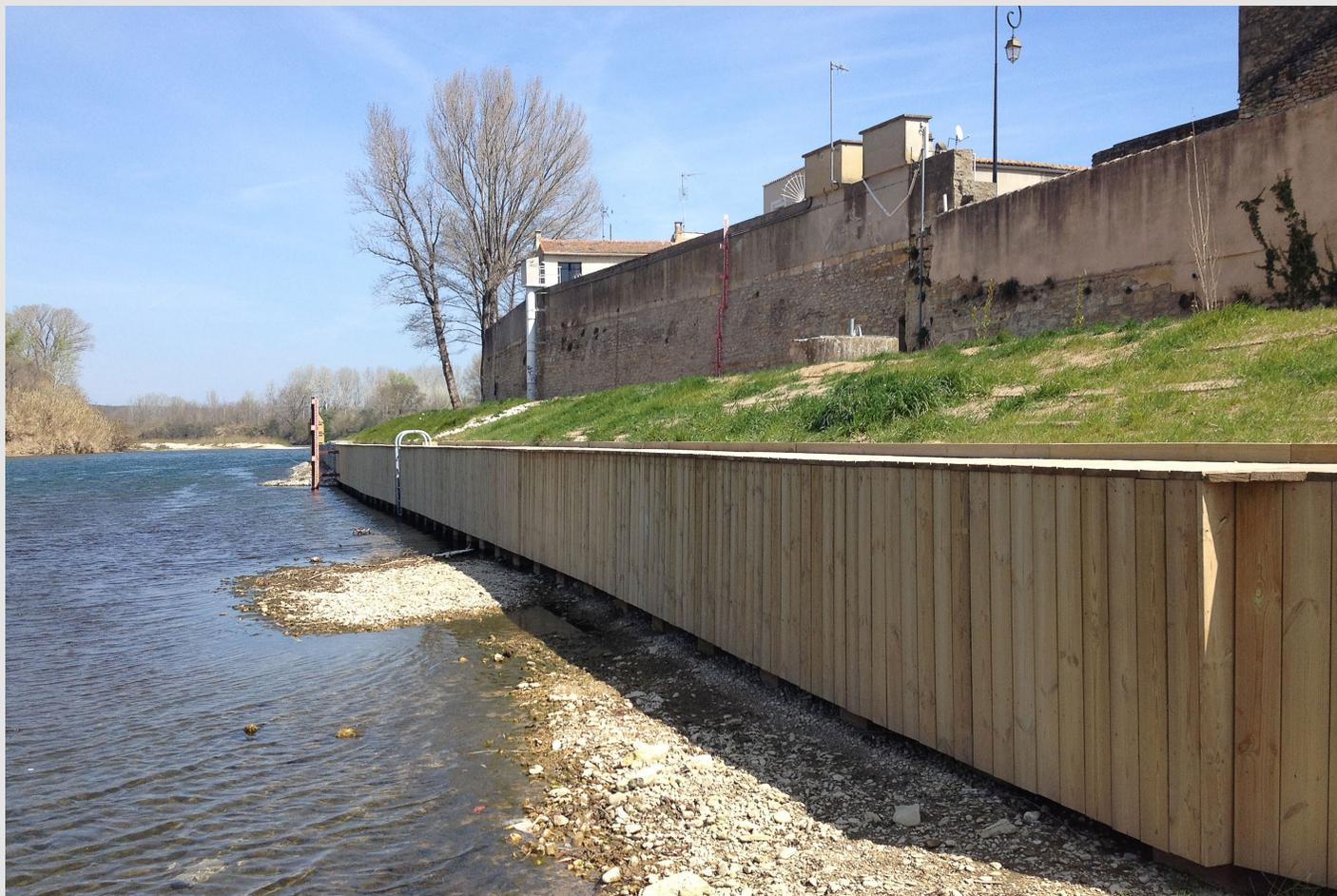
**PHOTO 3 - Protection de berge au pied de la digue de Remoulins**
